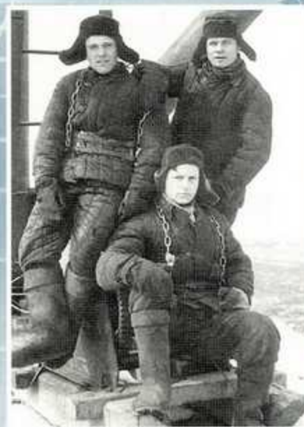
Г.В. Мозилевский, А.П. Воловик на монтаже антенно-мачтовых сооружений
