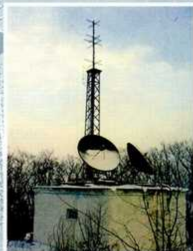
Типовой маломощный ретранслятор
