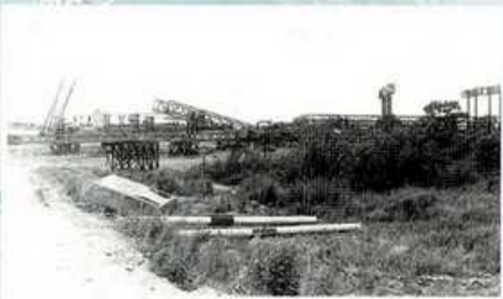
Строительство коротковолновых антенн. Подготовка к подъему, 1980 г.
