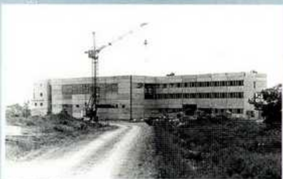
Строительство технического здания № 3, 1979 г.
