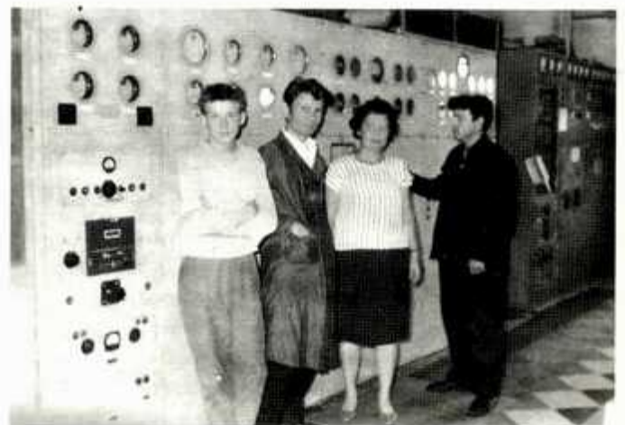
РВ-32 перед демонтажем
