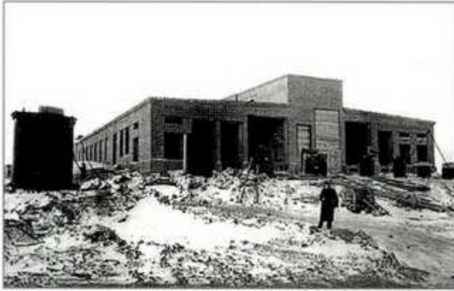
Начало строительства объекта № 762
