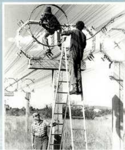
Работники АМС проводят профилактику на антенном фидере
